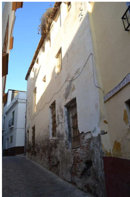
Cuartel de Almuñécar (Fuente: Oriol Closa)
